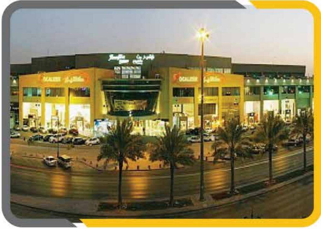
مبنى لوكاليزر مول الرياض - شارع التحلية - صيانة التكييف المركزي
